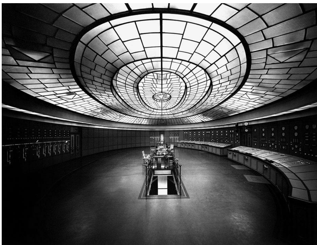
Kelenföldi Erőmű, Vezénylőterem, 1931. Fotó: Kozelka Tivadar
